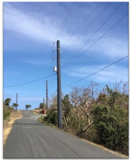
Refuerzo de la Infraestructura
